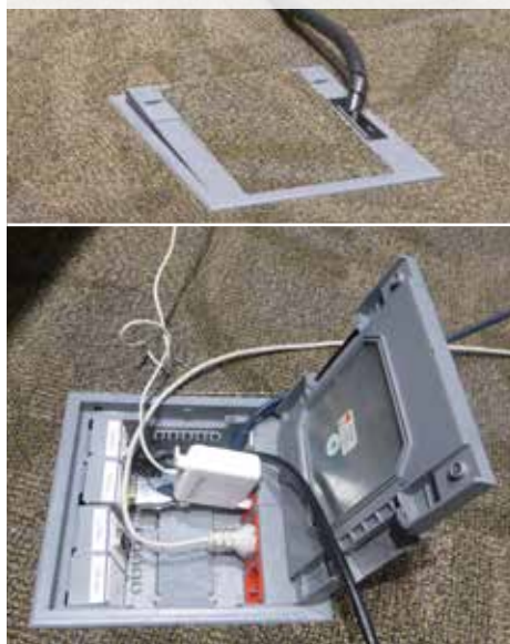
Лючок в полу для подключения электропитания, компьютерных и видеокоммуникаций
